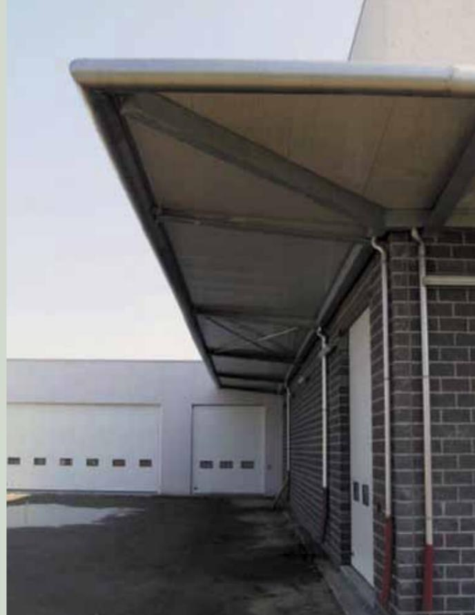
La struttura delle pensiline è costituita da elementi in acciaio zincato a caldo, verniciata, imbullonata e saldata per dare maggiore resistenza. Gli elementi principali sono reticolati, tutti a sezione circolare per avere una corretta distribuzione dello scarico del peso a terra. Vengono montati equidistanti con plinti in calcestruzzo armato e collegati tra loro con elementi tubolari.
